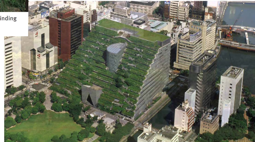
ACROS Fukuyoka - 1994, Emilio Ambasz, kantoorgebouw Figuur 10
